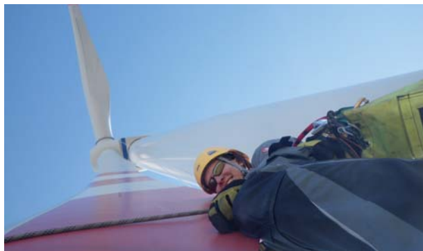
Expertin bei der Sichtprüfung am Rotorblatt
